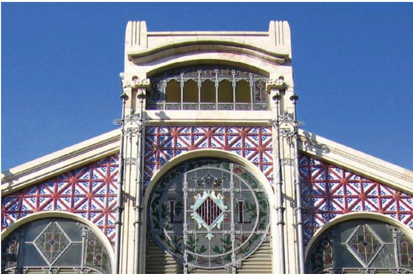
Figura 43. Fachada del Mercat Central de València, con azulejos de reflejo metálico
