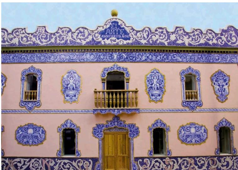
Figura 57. Juan Bautista Huerta Aviño fue un ceramista virtuoso del reflejo metálico que usó en el revestimiento de este edificio (1922), combinado con azul de cobalto sobre fondo blanco.
