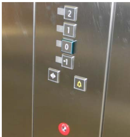
Botones de color contrastado, con números en braille y altorrelieve. Señales de emergencia con testigo luminoso.
