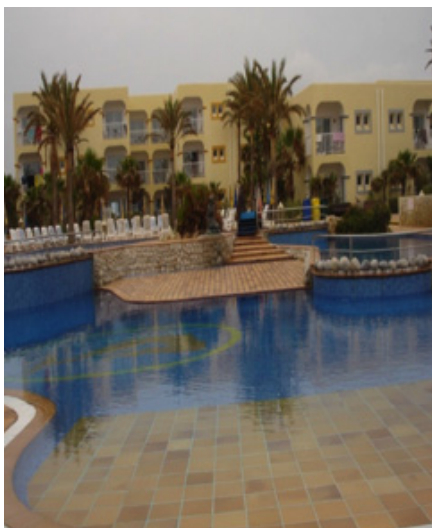
Acceso al vaso de la piscina tipo playa
