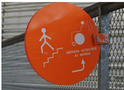
Ejemplo de señalización de la entrada accesible.
