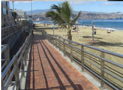
Ejemplo de paseo marítimo accesible y rampa de acceso a la playa.
