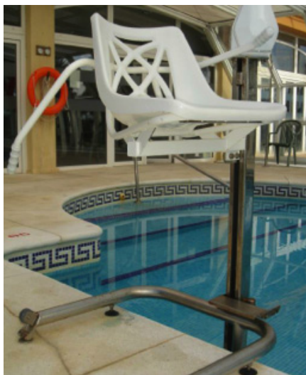
Acceso al vaso de la piscina con silla hidráulica
