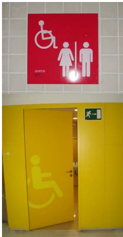
Ejemplo de señalización de cabina de aseo adaptada.
