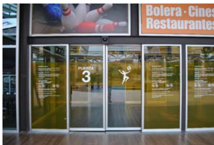
Ejemplo de señalización de puertas y mamparas de vidrio.
