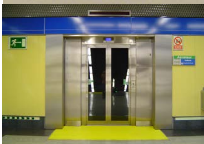
Señalización del número de planta en braille y en alto-relieve. Franja de señalización frente a puerta de ascensor con pavimento de color contrastado y con textura de acanaladura homologada.
